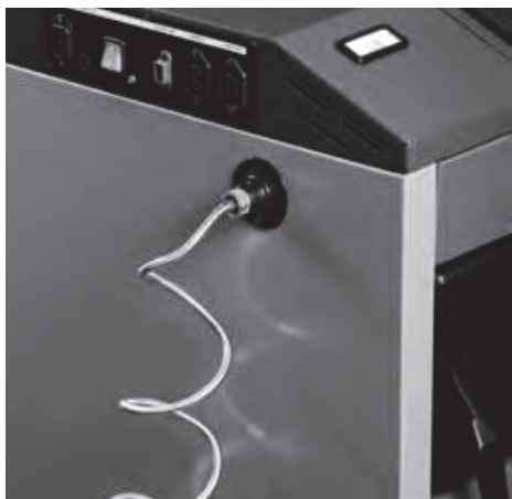
Obrázek 5 Místo montáže snímače teploty s kapilárou – bezpečnostní ventil tepelné ochrany
