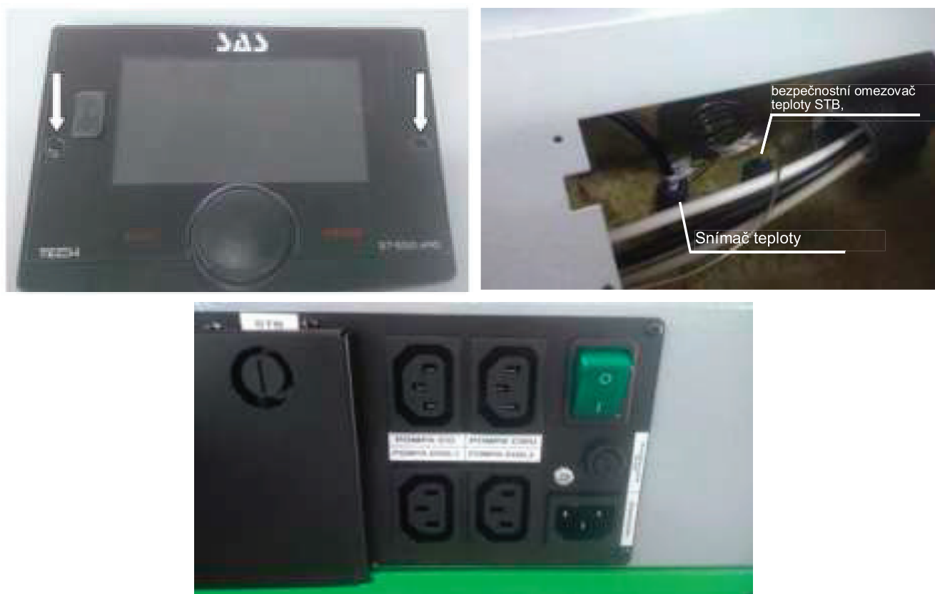
Obrázek 13 Umístění bezpečnostního omezovače teploty STB a teplotního čidla
